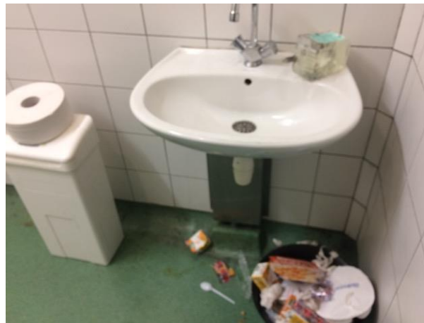
Figure 10 : lavabo implanté dans la même pièce que la douche
