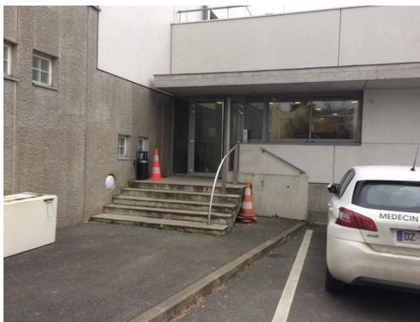
Figure 2 : porte d'entrée sur l'arrière du bâtiment
