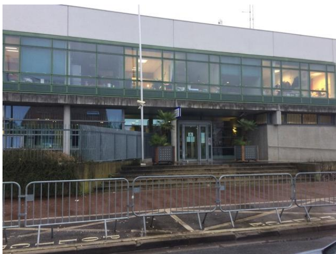
Figure 1 : l'entrée principale sur la rue Delerue
