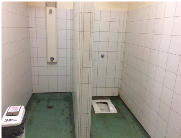
Figure 9 : douche et WC réservés aux personnes privées de liberté
