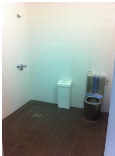
Douche et toilettes
