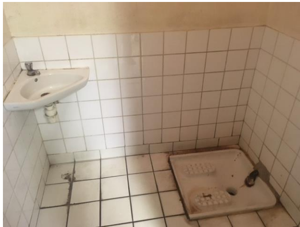
Le local sanitaire commun aux cellules de garde à vue
