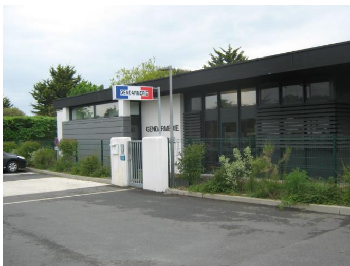
La façade des locaux de service
