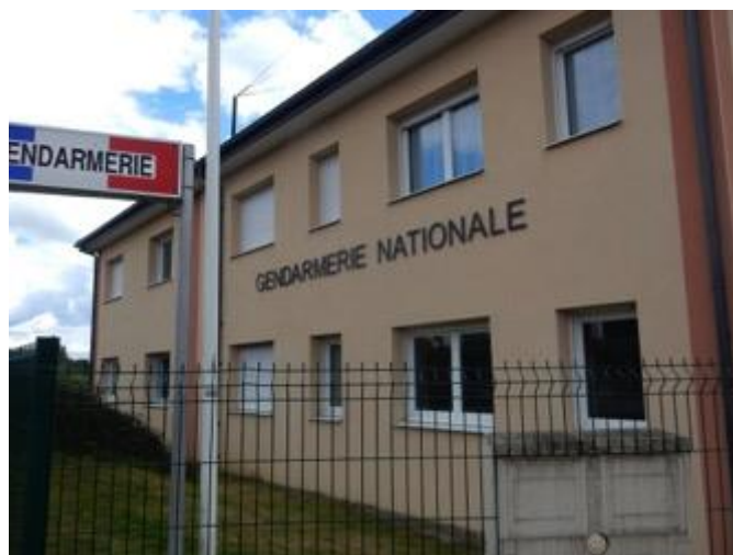
Façade de la brigade
