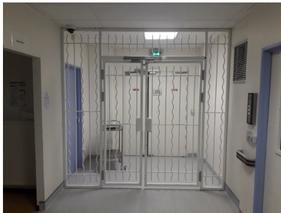
Le sas d'entrée de l'unité fermée au 1 er étage du bâtiment Marion
