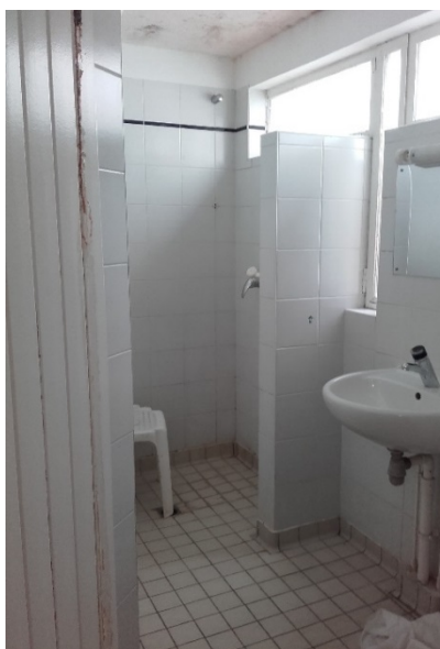
Salle de bains collective
