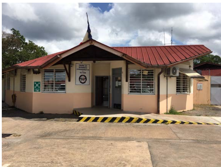
Entrée du CRA de Cayenne
