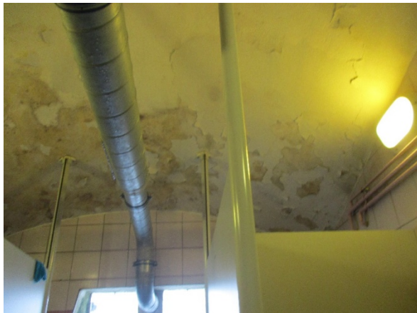
Le plafond d'une salle de douche
