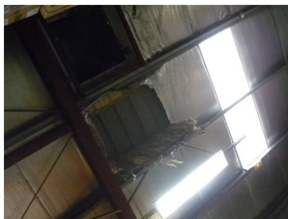
Toiture de l'atelier
