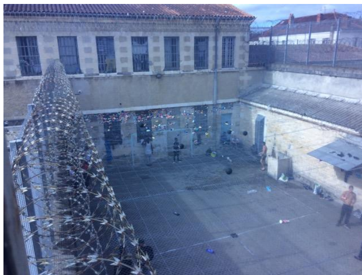
Figure 6 : la cour "ouest" photographiée depuis le poste de surveillance
