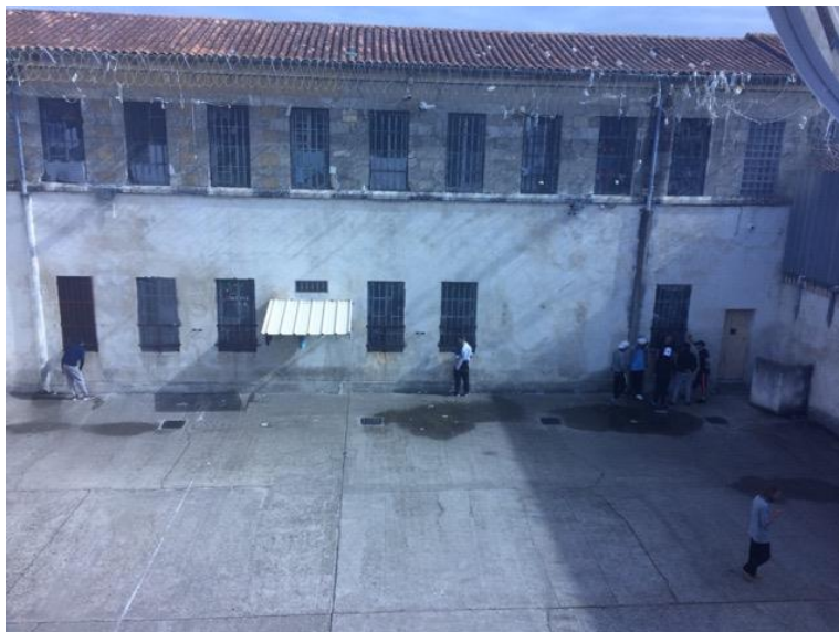
Figure 7 : la cour "est" vue depuis le poste de surveillance
