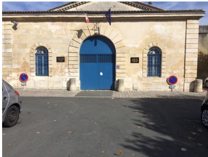
Figure 11 : la porte d'entrée principale de l'établissement
