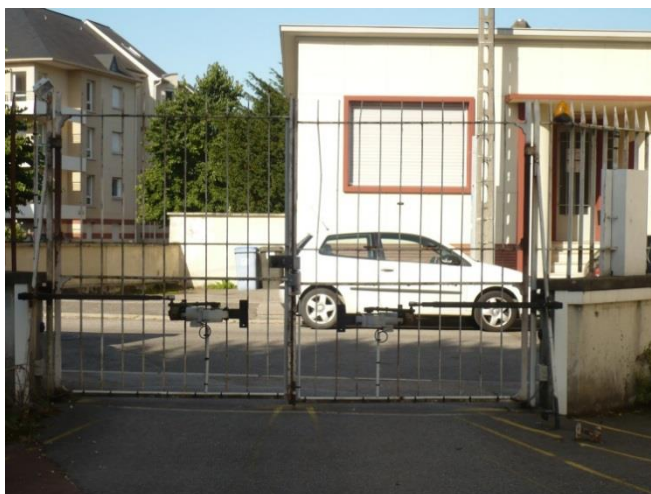
Grille d'entrée du parking
