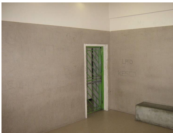
Vue de la cellule collective réservée aux personnes déférées
