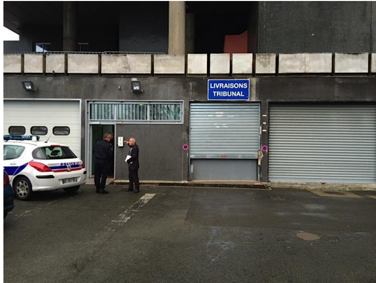
Photographie 2 : les entrées véhicules et piétons du dépôt
