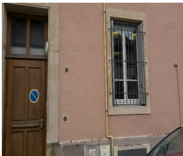
Photo 2 : entrée à l'arrière du TGI de Belfort
