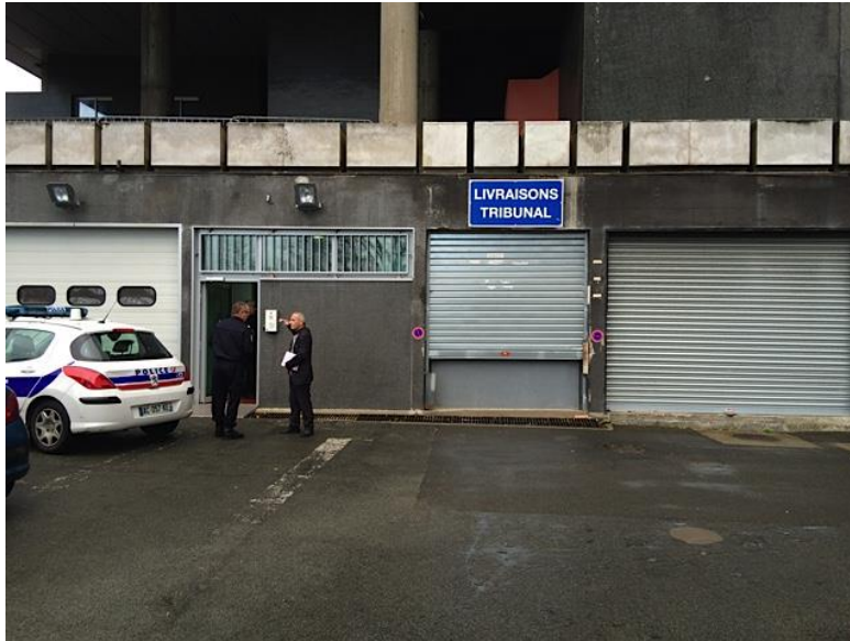
Les entrées pour les véhicules et piétons du dépôt
