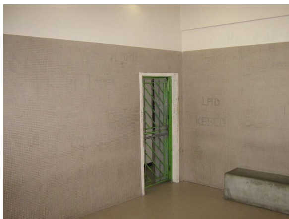
Vue de la cellule collective réservée aux personnes déférées
