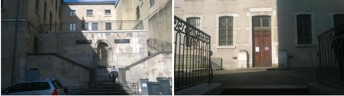
Les escaliers donnant accès au TGI et de la porte du TGI
