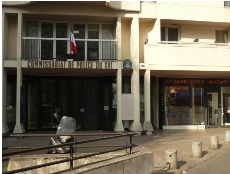
Entrée du commissariat central, avenue Mozart
