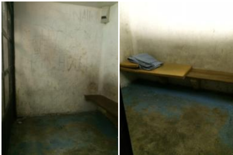
Des cellules de garde-à-vue
