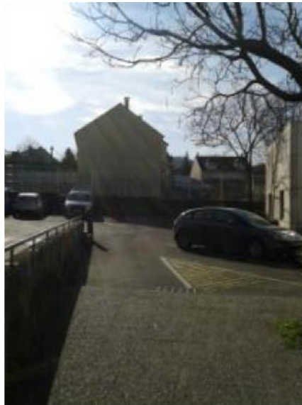
La cour intérieure et la maison mitoyenne
