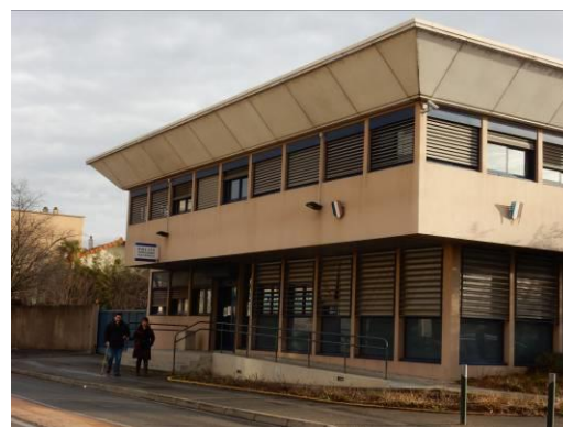
Entrée accessible par rampe pour PMR
