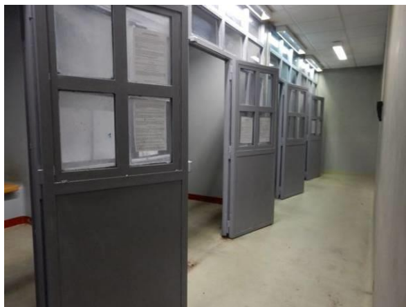
Couloir des locaux de sûreté
