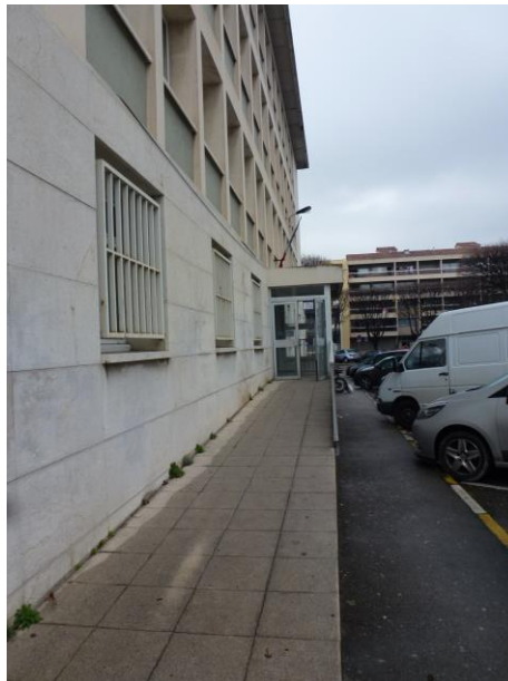
L'entrée du commissariat pour les PMR
