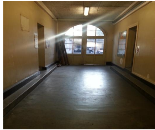
Entrée du n°36
