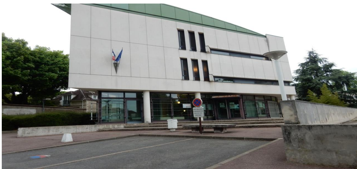
Places de stationnement des véhicules de police et vue sur les entrées du poste de police
