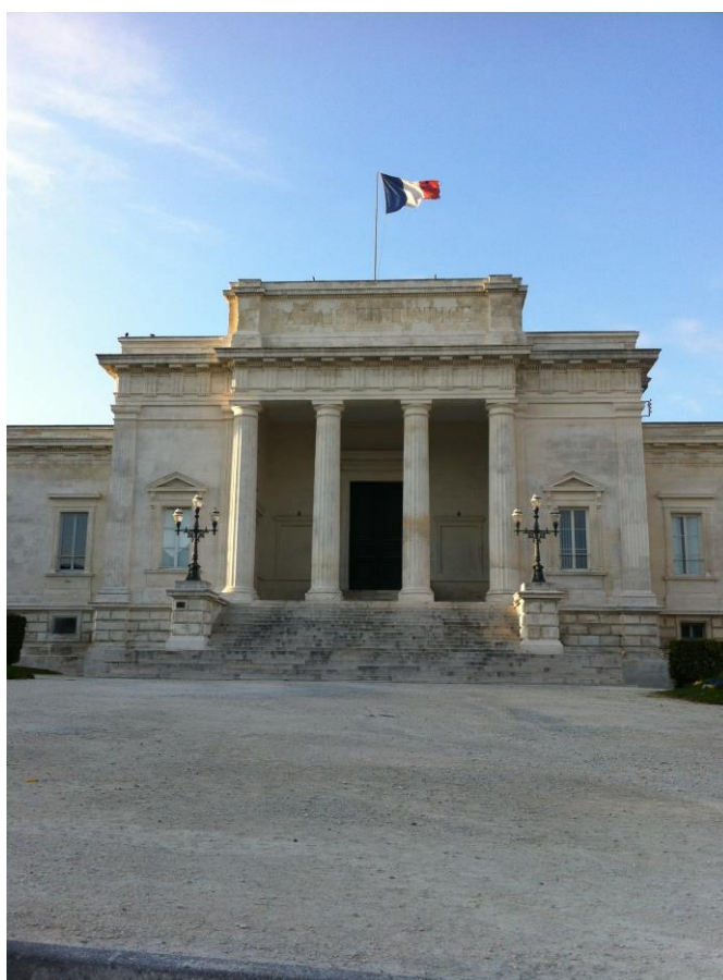
Entrée principale du palais de justice de Saintes
