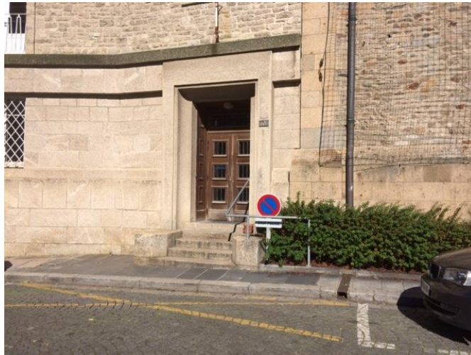
Porte de service rue Toullier
