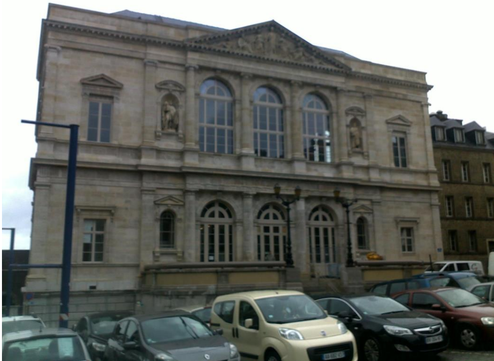
Façade de l'ancien palais
