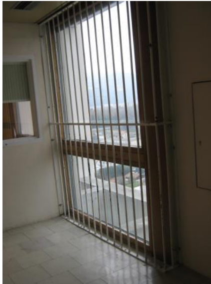
Les barreaux placés à l'intérieur de la chambre
