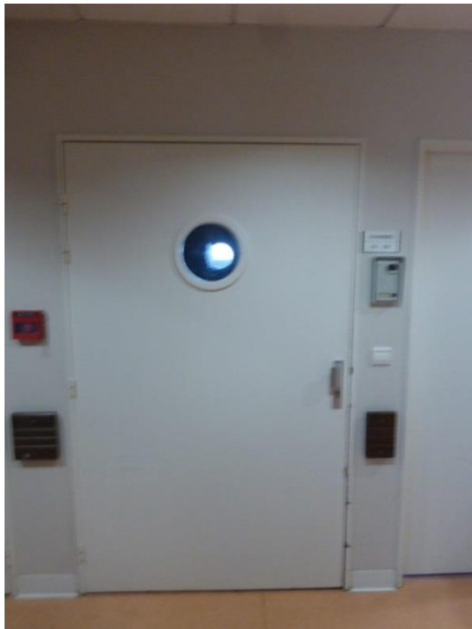
Porte d'accès au sas
