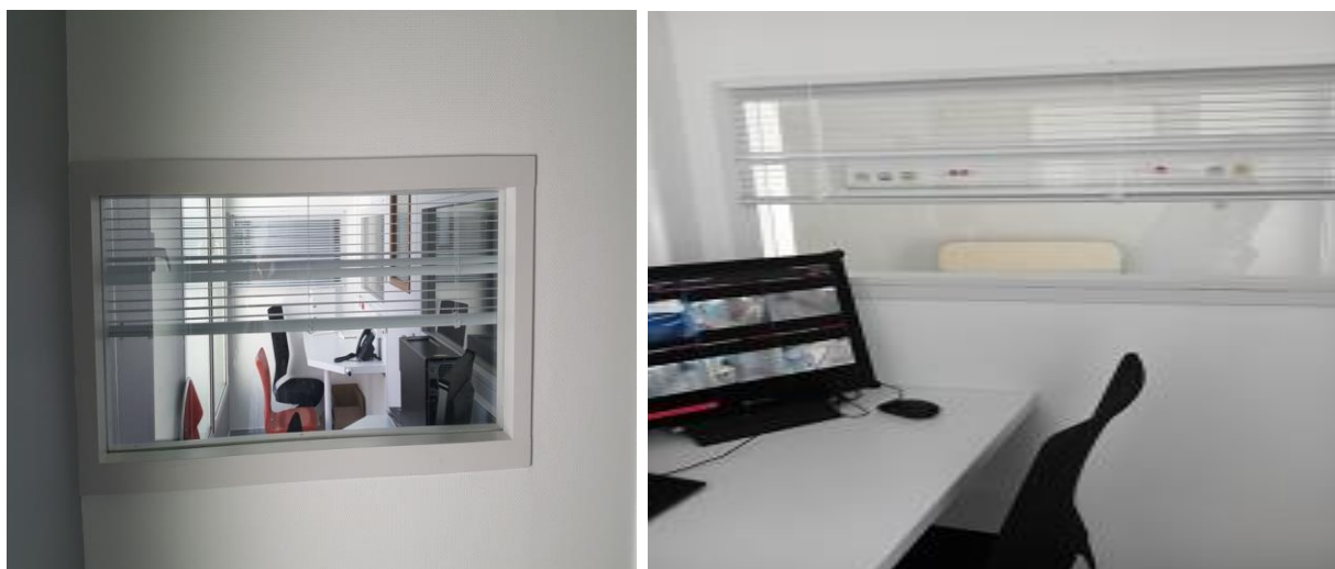
Poste de surveillance vu du sas Vue depuis le poste de surveillance sur une chambre sécurisée
