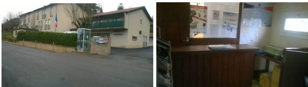
Vues de la route de la BP de Sousceyrac et de l'accueil du public
