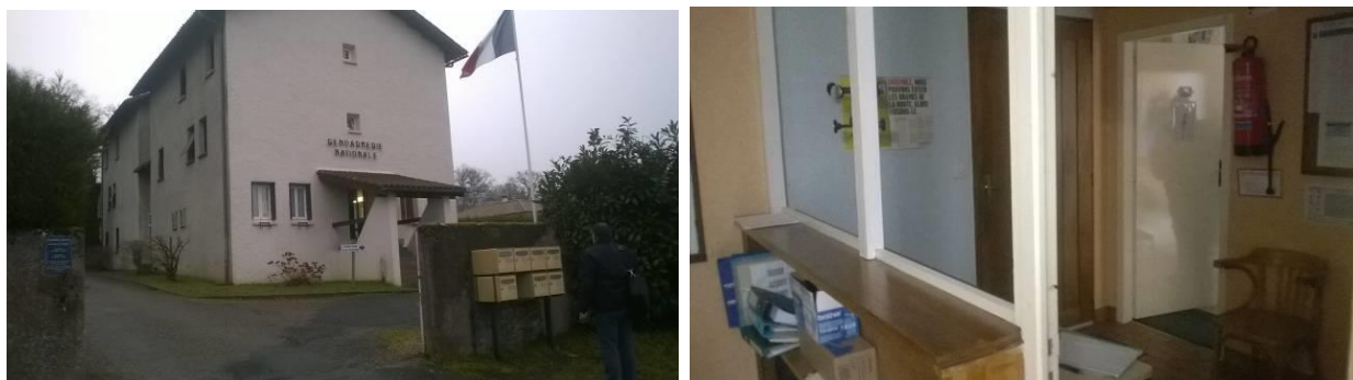
Vues de l'accès de la BP de Latronquière et du local d'accueil
