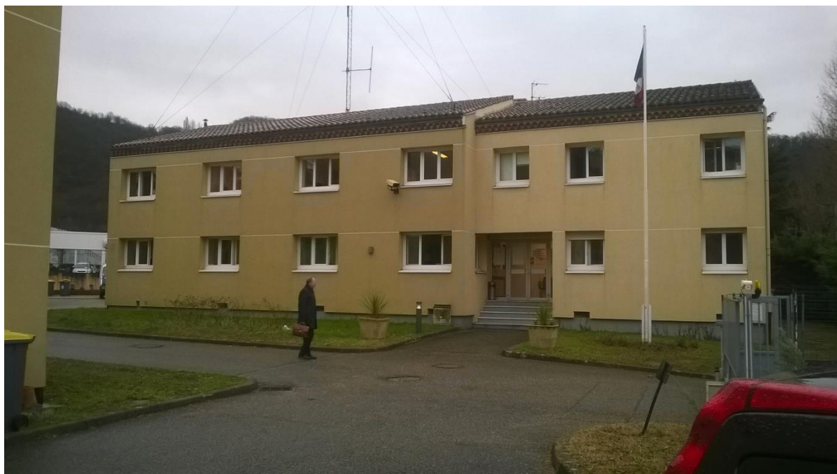
Photo du bâtiment et de l'accueil des visiteurs à la BP de Vienne-Sud
