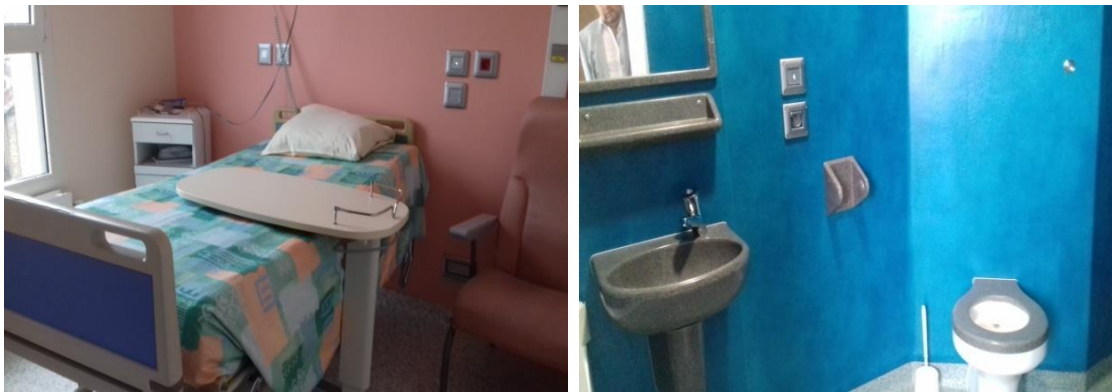
Chambre sécurisée et salle d'eau dans sa configuration conventionnelle
