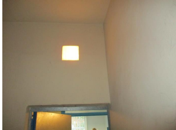
L'éclairage électrique au-dessus de la porte d'une chambre de sûreté
