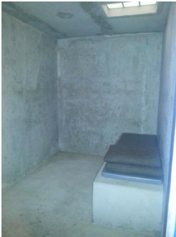
Le bat-flanc et le bloc de verre d'une chambre de sûreté
