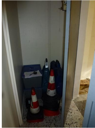
Couloir des cellules encombré
