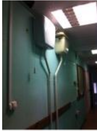
Lumière et chasse d'eau à commande extérieure
