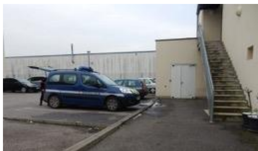
Arrière du bâtiment
