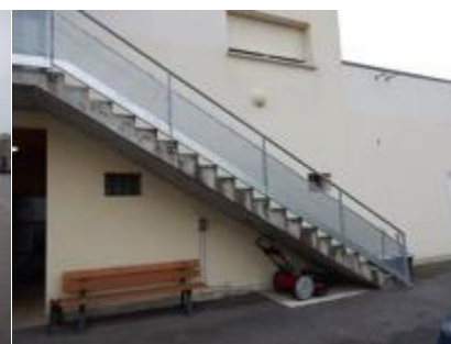
Arrière du bâtiment
