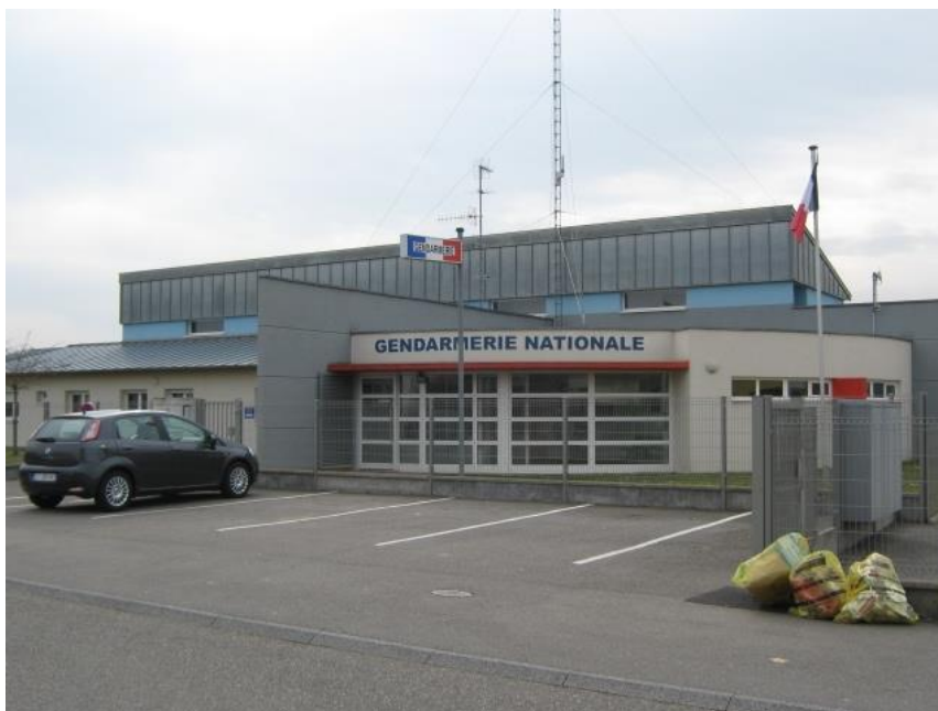
La façade des locaux de service de la brigade
