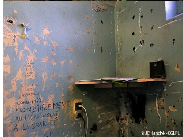
Cellule non rénovée
