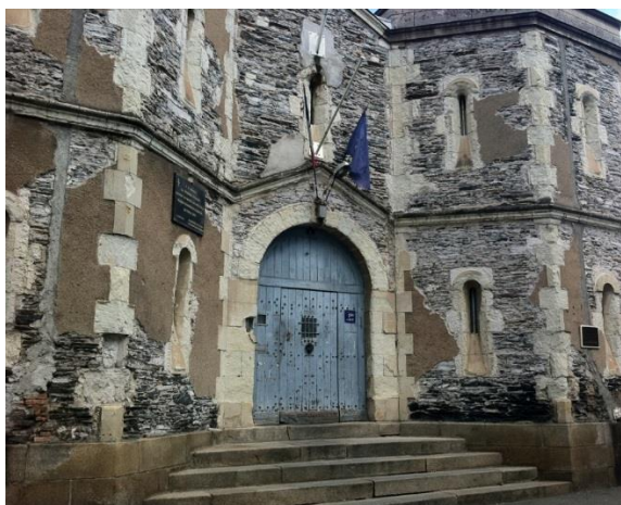
Porte d'entrée extérieure
