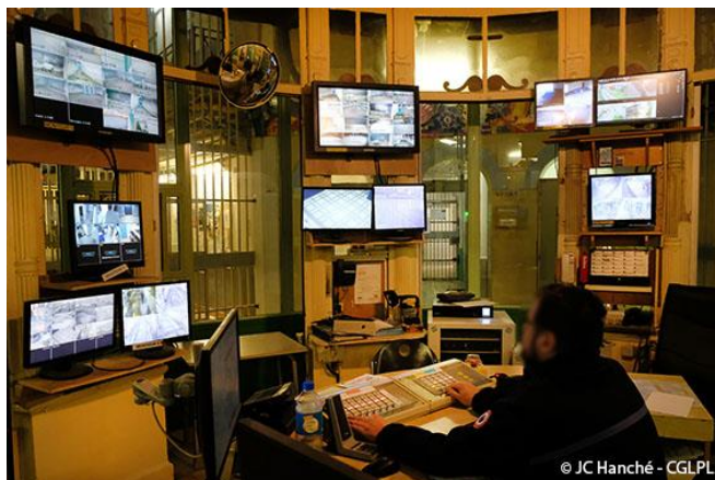
Vue des écrans depuis le poste central de la rotonde
