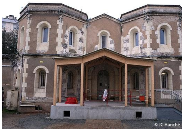
Travaux de réfection de la porte d'entrée, vue de l'intérieur de l'établissement
