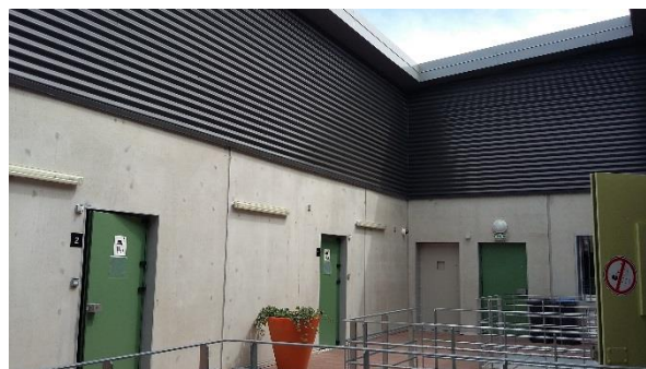
Entrée des UVF
