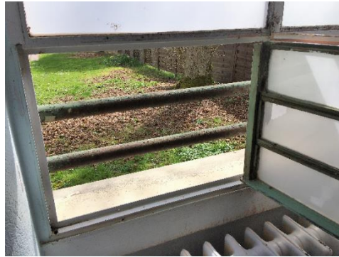
La fenêtre de la chambre d'une unité ancienne
