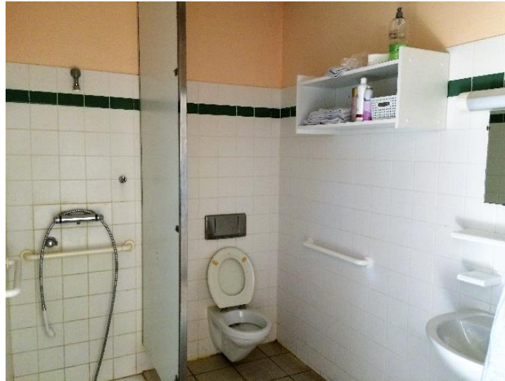
Salle d'eau dans une chambre individuelle (unité remodelisée)
