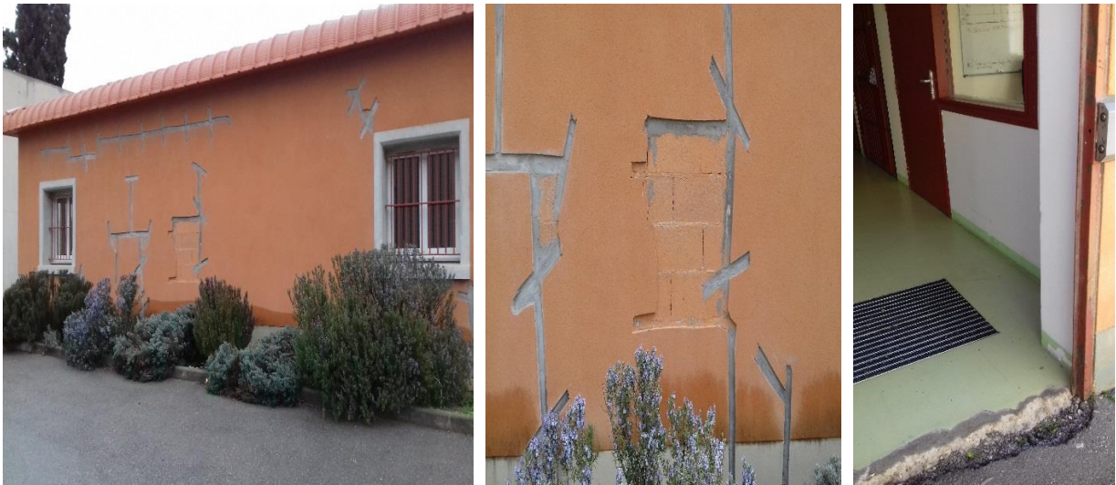
Façade du quartier disciplinaire et pas-de-porte
