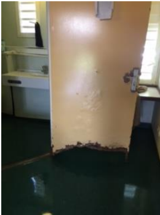
Une porte d'une salle d'eau
