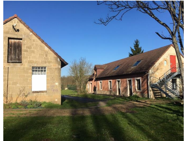
Deux bâtiments pour activités
