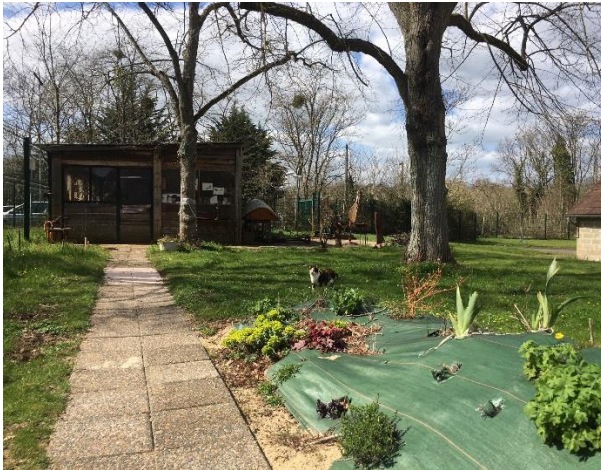
Bâtiment des activités sculpture et métallerie
