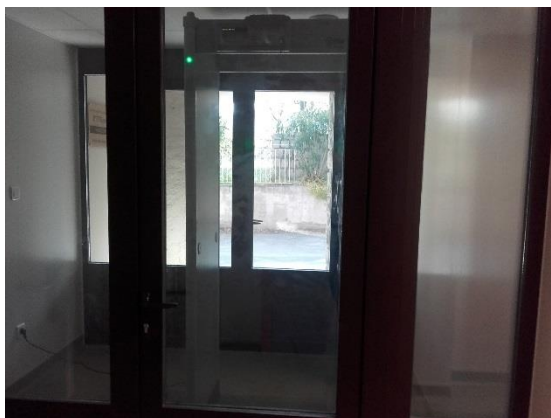
Le deuxième accès à l'unité, avec portique de détection des masses métalliques
