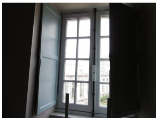
Les fenêtres des chambres
