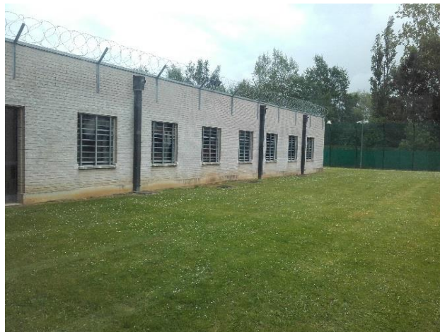
Un bâtiment d'hébergement
