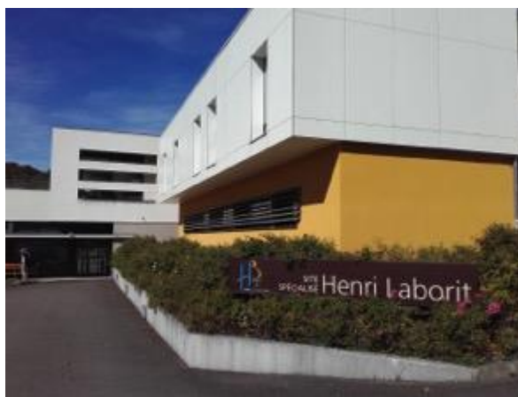
Façade du site Henri Laborit
