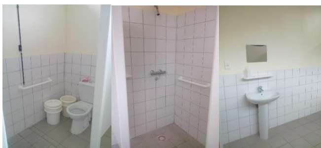
Sanitaires des chambres d'isolement, unité Rochebrune
