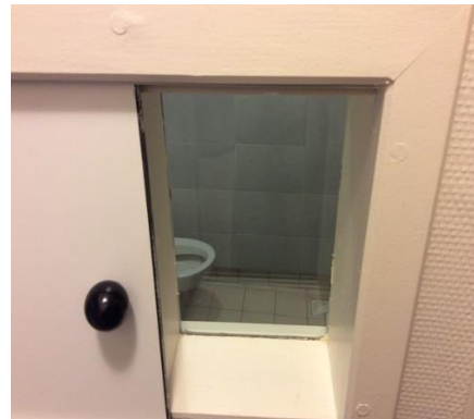
Trappe donnant sur une chambre d'isolement
