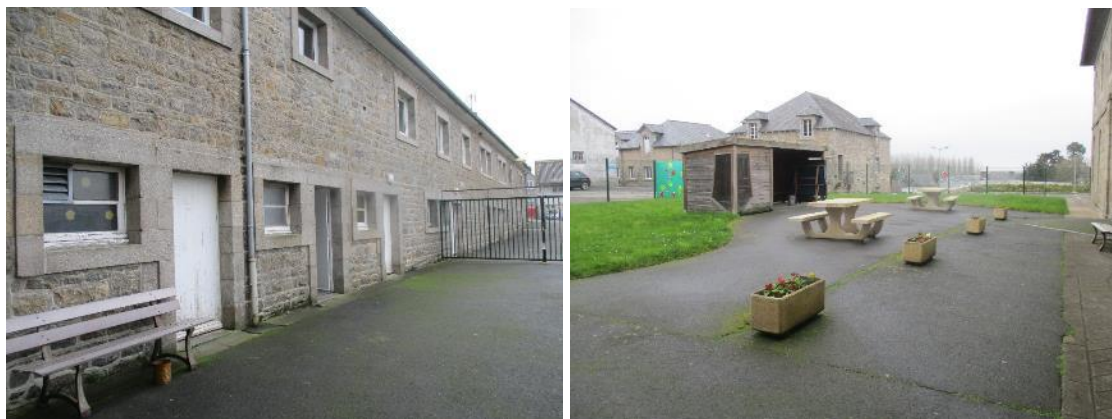
La cour de Saint-Bernard avec, sur la gauche, l'accès aux sanitaires et à la buanderie
