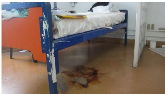
Cellule du quartier d'isolement
