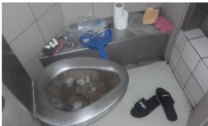
Sanitaire individuel en cellule au quartier des mineurs
