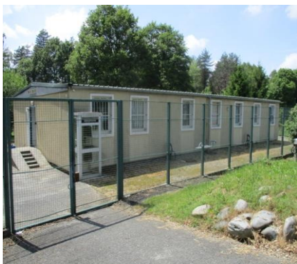
Le CD vu depuis son portail d'accès
